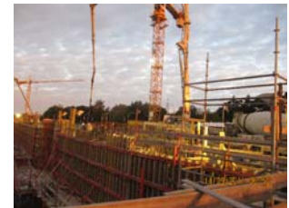
Letzte Großbetonage der Wand W20 am 14. Sept.
