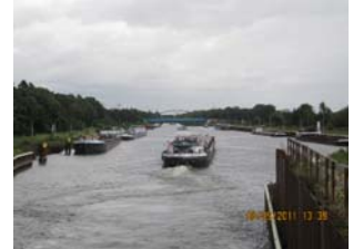
Aufrechterhaltung des Schiffsverkehrs während der Bauausführung der neuen Schleuse
