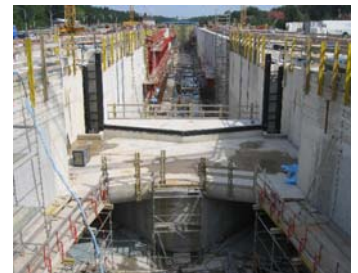
Bild 1: Neubau 2. Schleuse Wusterwitz Blick in die Baugrube
