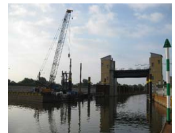
Bild 2: Niedrigwasserschleuse im Sept. 2011 mit Rammarbeiten am Leit- werk des Oberhauptes
