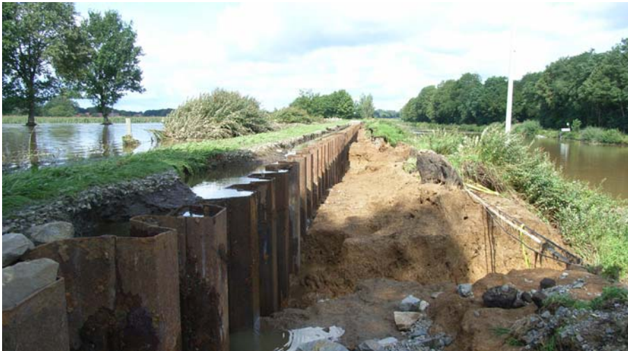
Kurz nach dem Hochwasser: Die Spundwand verhinderte größeren Schaden
