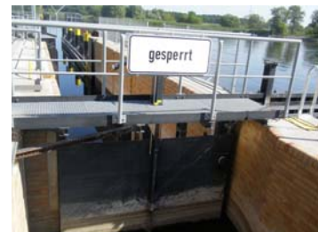
30.5.2011 – Neue Kahnschleuse Verkehrsfreigabe voraussichtlich ab 17.6.2011
