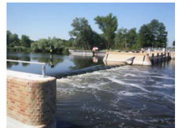
30.5.2011 – Neues Wehr Bahnitz
