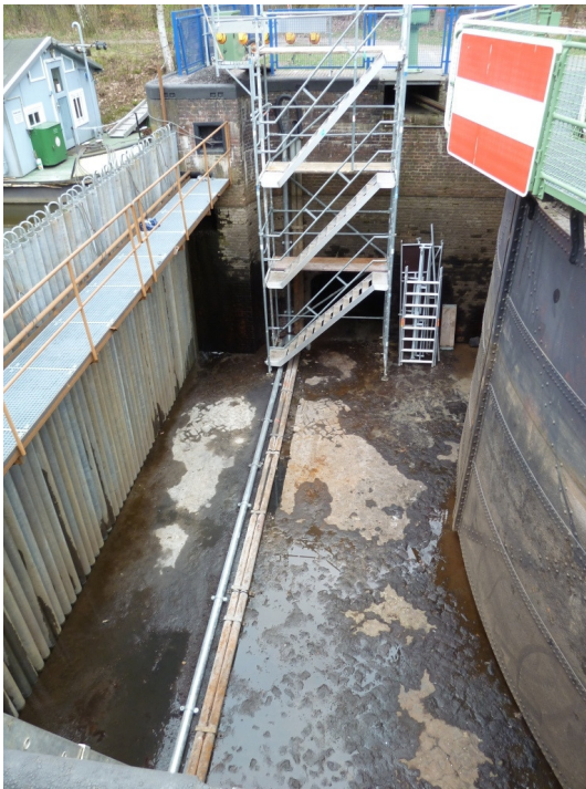
Trockengelegtes Schleusenoberhaupt in Bannetze
