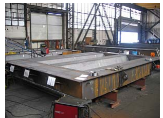
Fertigung der Stemmtore bei SIBAU in Genthin
