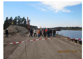
Führung im Oberen Vorhafen mit Gerätepark des Wasser- baus
