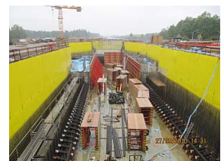
Schal- und Bewehrungsar- beiten in der Baugrube
