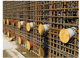
Einbau der Fülldüsen zwischen Längskanal und Schleusenkammer
