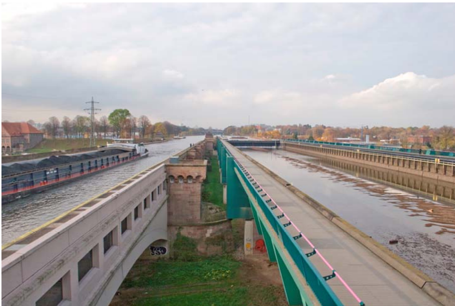
Trockenlegung der neuen Kanalbrücke im Herbst 2009. Die Schifffahrt lief währenddessen über die alte Kanalbrücke.
