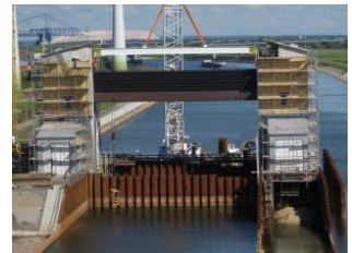
Obertor ist in Torschiene eingefädelt und wird weiter bis zur Sohle absenkt
