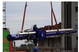
Entladen des Hydraulikzylinders
