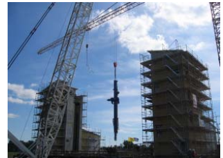
Schwimmkran hebt Hydraulikzylinder zur Einbauposition
