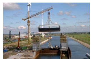
Einbau Obertor durch Schwimmkran
