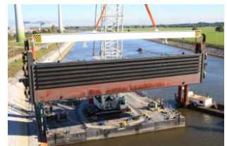
Antransport des Obertors durch den Schwimmkran
