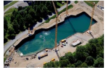
17.06.2010 – Luftaufnahme von der Baugrube vor dem Abpumpen des Baugrubenwassers
