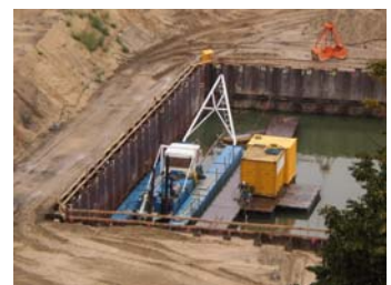
06.09.2009 – holländischer Schwimmbagger beim Bodenaushub in der Baugrube
