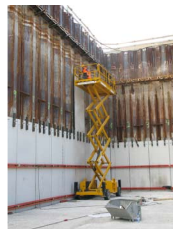
24.08.2010 – Einbau von Filigranplatten als „verlorene Schalung“ für die spätere Betonage des Fundamentes
