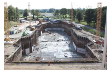
17.08.2010 – Blick in die fertig gestellte Baugrube
