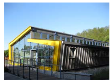
Das neue Informationszentrum der Wasser- und Schifffahrtsverwaltung des Bundes
