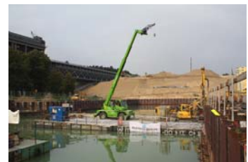
23.09.2009 – Einbau von Auftriebspfählen für die Baugrubensohle vom Schwimmponton aus
