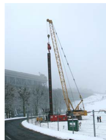
20.02.2009 – Beginn der Rammarbeiten für die Herstellung der Baugrubeneinfassung
