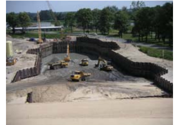
24.06.2009 – Trockenaushub in der Baugrube
