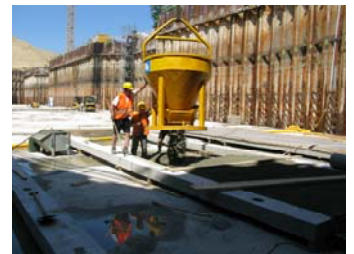
09.07.2010 – Einbau von Dränbeton mittels „Bombe“
