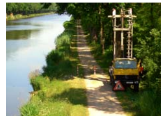
Kernbohrung am DEK
