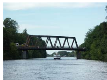
Ansicht alte Nedlitzer Südbrücke
