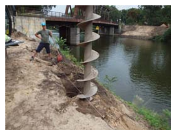
23. August 2010 – „Lockerungsbohrungen“ zur Herstellung der Baugrube für ein neues Brückenwiderlager
