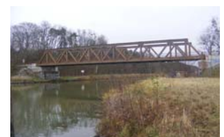
Ab 23.08. Sperrung der alten Brücke und Rückbau bis zum 25.08.
