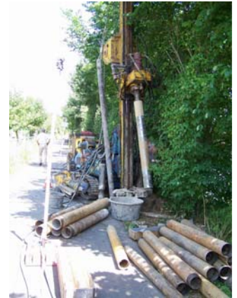
Bohrgerät im Einsatz
