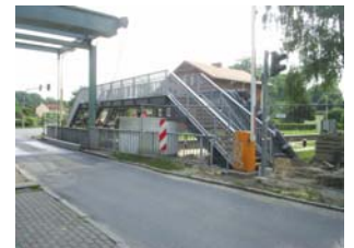
Fußgängerbrücke Neue Mühle
