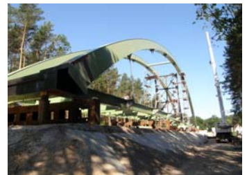
29. Juni 2010 – Vormontage des Brückenüberbaus aus Stahl auf der östlichen Brückenrampe
