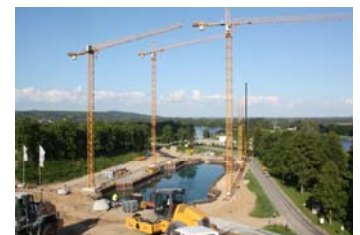
05.06.2010 – vier Turmdrehkrane für das neue Hebewerk
