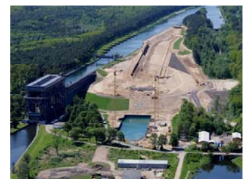
05.06.2010 – Luftbild vom Bau- feld in Niederfinow
