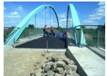
26.05.2010 – letzte Arbeiten zum Aufbringen der Deckschicht auf der Brückenfahrbahn
