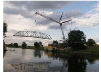
24.07.2009 – Rückbau der alten Wegebrücke Stolzenhagen
