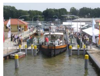
06.06.2010 – Neue Schleuse Fürstenberg in Betrieb
