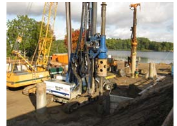
08.10.2009 – Ballett der Bagger
