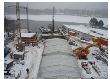
19.01.2010 – Arbeiten bei -10°C, unter einem beheizten Zelt
