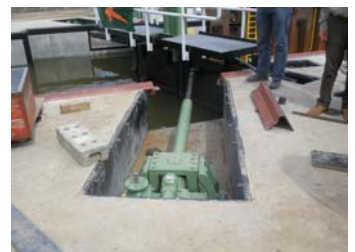
26.04.2010 – umweltfreundliche und wartungsarme Antriebe mit Elektrohubzylindern
