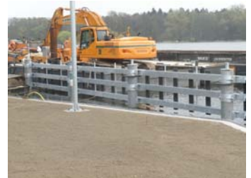
26.04.2010 – moderne Ausrüstung der neuen Wartestellen, hier im Unteren Vorhafen
