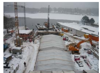
14.01.2010 – komplett eingehauste und beheizte Baustelle
