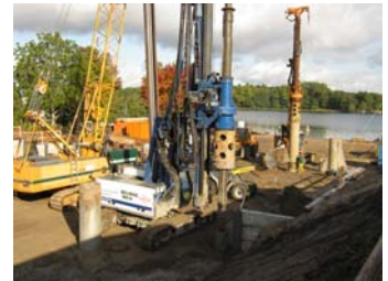
08.10.2009 – Ballett der Bagger
