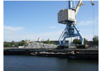
Umschlag von Baustoffen an der modernisierten Kaianlage im öff. Binnenhafen Eisenhüttenstadt
