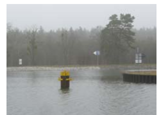
Wendestelle von Süden am Abzweig zur ehemaligen Schleusentreppe
