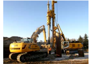
04.03.2010 – Baubeginn für die neue Straßenbrücke Hohensaaten
