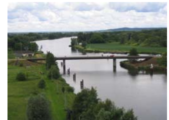
Ansicht alte Straßenbrücke Hohensaaten (05.03.2007)
