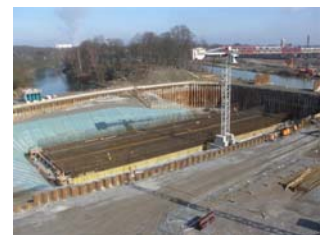
Blick in die Baugrube
