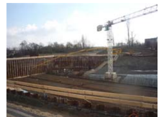
Stellprobe der Betonpumpe
