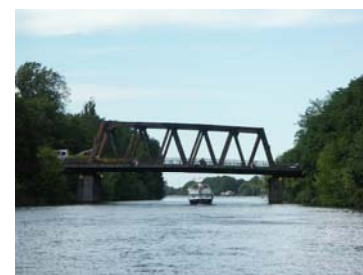
Ansicht alte Nedlitzer Südbrücke
