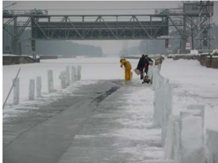
Winterarbeiten an der Kanalbrücke (Eissägen zur Druckentlastung)
