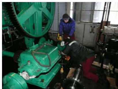
Trograntrieb Südwest – Windwerk zum Drehriegel
