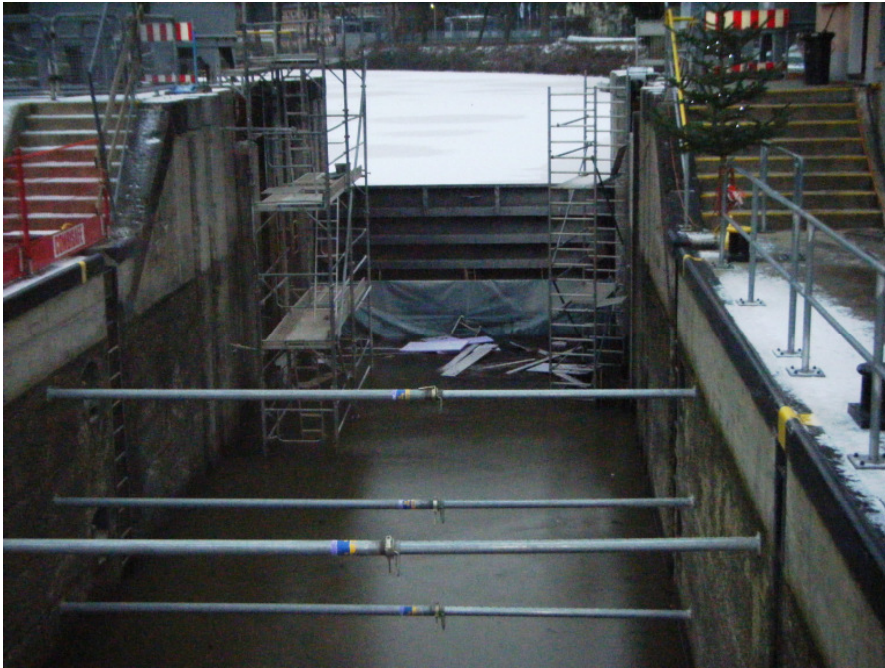
Bild: Überflutete und zugefrorene Schleusenkammer
