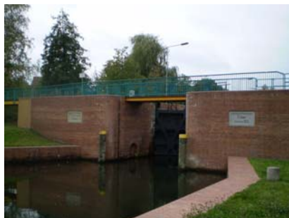
Schleuse Eberswalde von Unterwasser
