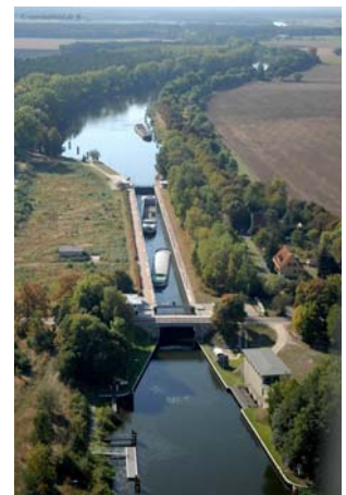
Luftbild 1. Schleuse Zerben mit Straßenbrücke über das Unterhaupt, Standort der neuen Schleuse achsparallel auf der Freifläche
