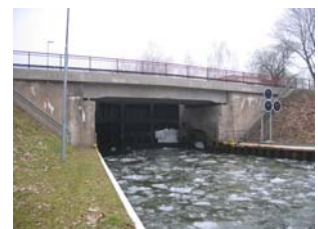
Straßenbrücke über das Unterhaupt der 1. Schleuse
