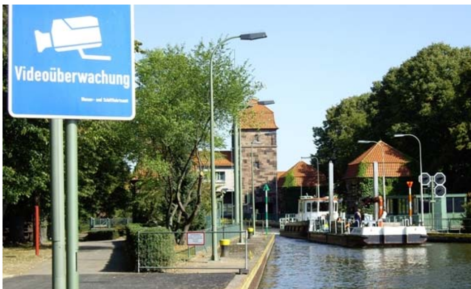
Die Schachtschleuse Minden – jetzt im fern bedienten Betrieb
