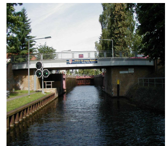
Blick in die geöffnete Schleuse von Unterwasser
