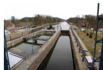
Ansicht Schleuse Kersdorf, Blick in Richtung Osten
