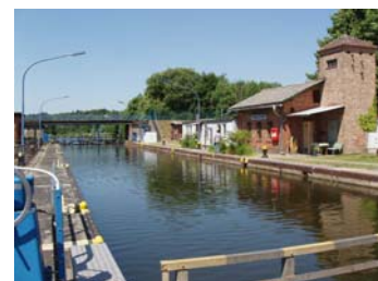
Ansicht Schleuse Kersdorf, Blick in Richtung Westen
