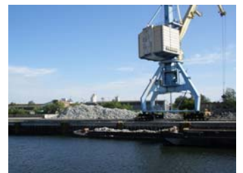
Umschlag von Baustoffen an der modernisierte Kaianlage im öff. Binnenhafen Eisenhüttenstadt
