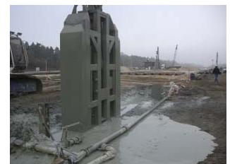
Bild 2: Dichtwandgreiferung mit suspensionsgefülltem Schlitz
