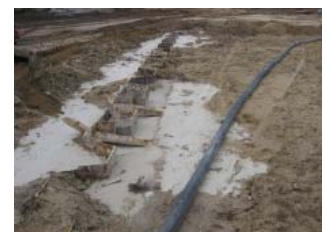
Bild 3: Fertig gestellte Lamelle mit eingehängter Spundwand
