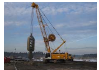
Bild 1: Dichtwandgreifer
