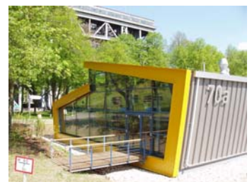
Das neue Baustelleninformationszentrum am Fuß des alten Hebewerks
