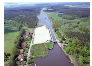
Luftbild Standort 2. Schleuse Wusterwitz
