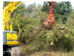
Rodungsarbeiten zu Beginn der Bauausführung Sept. 2008
