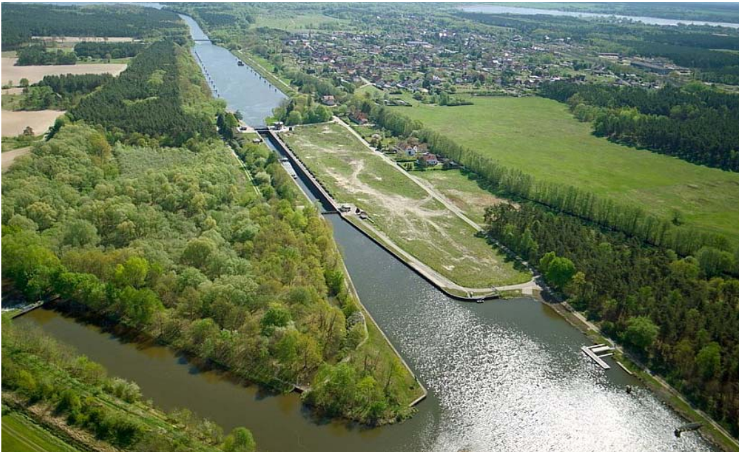
Bild 1: Luftbild von der Schleuse Wusterwitz: die Freifläche markiert den Standort der neuen Schleuse
