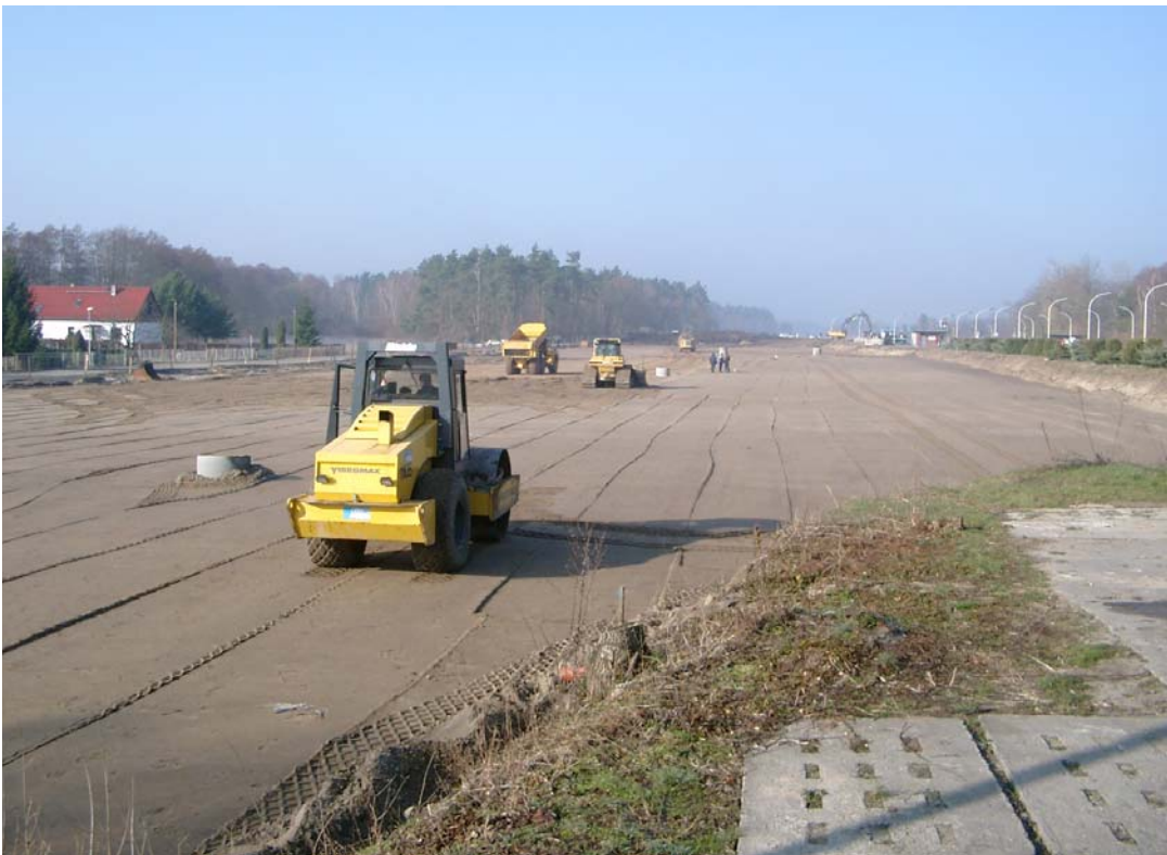
Bild 2: Bereits 2004 wurde eine großflächige Vorlast am Standort der neuen Schleuse aufgebracht. Dadurch wurden die baubedingten Setzungen der Schleuse zum Großteil vorweggenommen.
