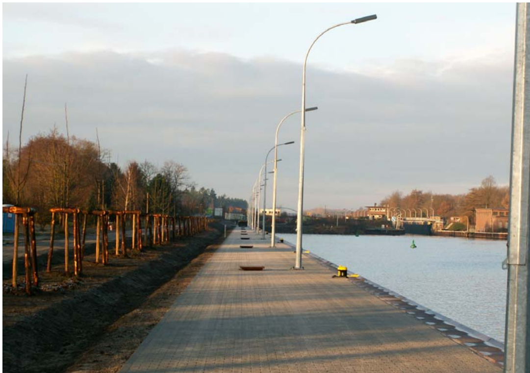
Bild 2: Die Planie auf der Südseite des neuen Unteren Vorhafens mit Lampen, Pollern und Leitern vollständig ausgerüstet kurz vor der Abnahme. Noch sind die Sperrtonnen rechts gesetzt, seit dem 12.12.07 sind dies nicht mehr erforderlich. Links sind die neu angepflanzten Bäume zu sehen.
