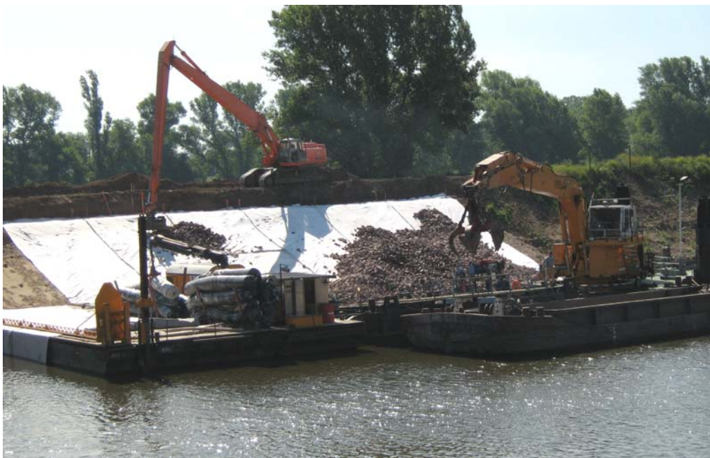
Bild 3: Auf dem Ostufer wird die neu profilierte Böschung mit Wasserbausteinen auf einem geotextilen Filter geschützt.
