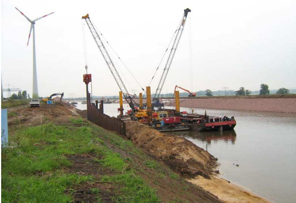
Bild 2: Auf dem Westufer wird vom schwimmenden Gerät aus die Spundwand im Oberen Vorhafen eingebracht.
