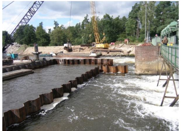
Das erste Wehrfeld soll im Herbst dieses Jahres fertiggestellt sein. Mit der Inbetriebnahme des Wehres ist Ende 2008 zu rechnen. Dann werden ca. 3000 m<sup>3</sup> Beton und rund 200 Tonnen Baustahl verarbeitet sein. Eine neue Brücke über das Wehr wird dann die höhengleiche Querung zwischen den Ufern möglich machen.
