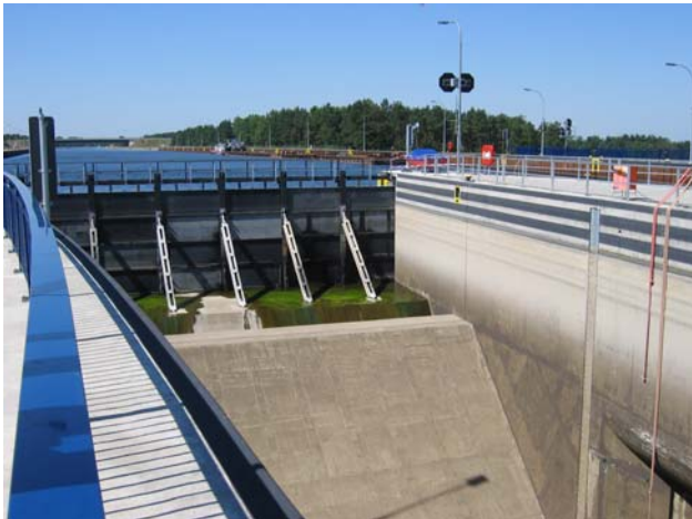
Bild 3: Gesetzter Revisionsverschluss am Ober- tor der Südhammer
