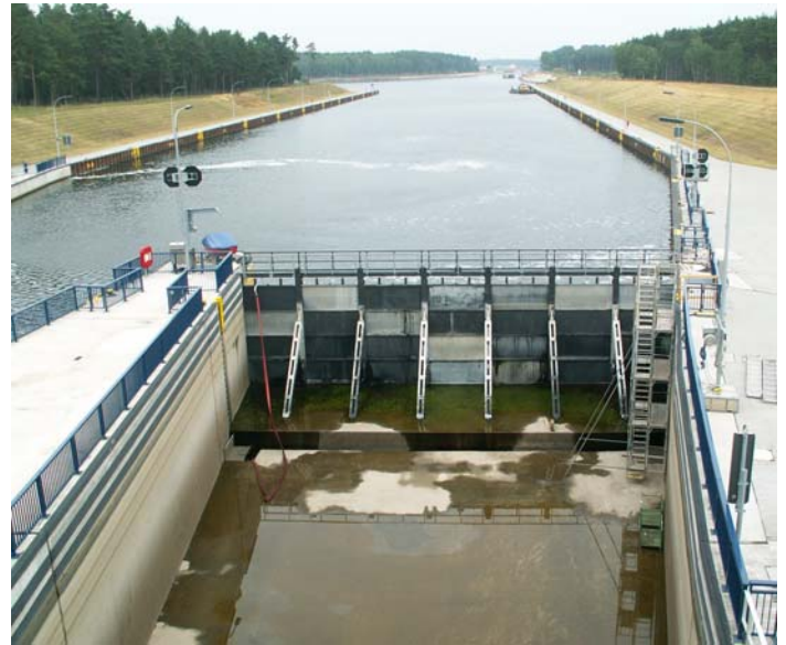
Bild 2: Gesetzter Revisionsverschluss des Untertores der Südhammer, im Hintergrund mit Blick auf das Niegripper Wendebecken
