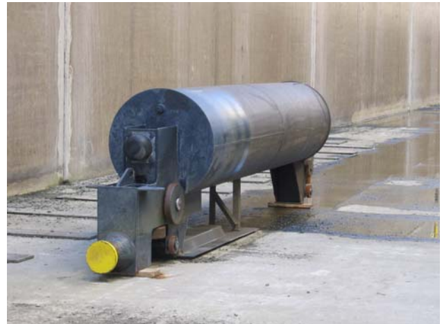
Bild 4: Schwimmpoller in ausgebautem Zustand und zur Inspizierung bereitgestellt
