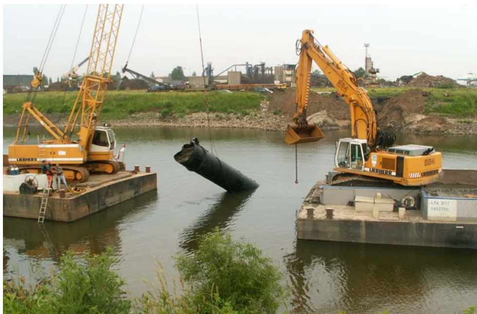
Bild 2: Rückbau BRABAG-Düker: Vom Ponton aus wird das gereinigte und in Segmente zerlegte Dükerrohr gehoben.
