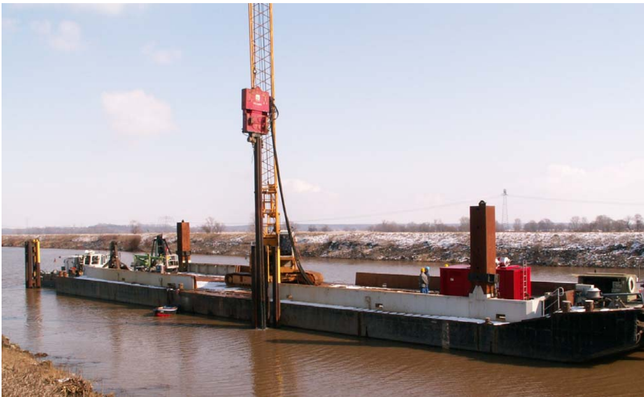
Bild 2: Ein Einzelpfahl eines Dalben wird mit einem Vibrationsbär gezogen
