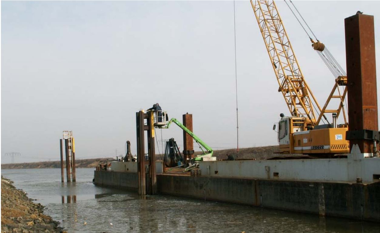
Bild 1: Die Verdingungsebenen der Anlegedalben werden vom Ponton aus abgebrannt
