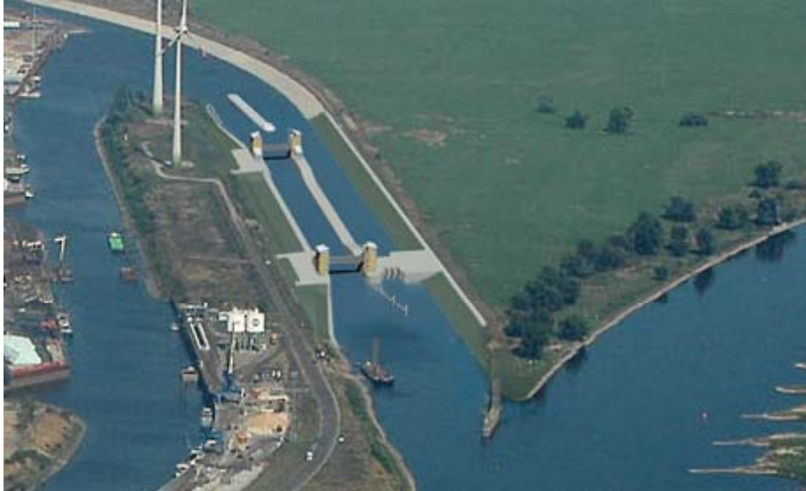
Bild 1: Niedrigwasserschleuse Magdeburg (Vision 2011) – Flugdienst Magdeburg
