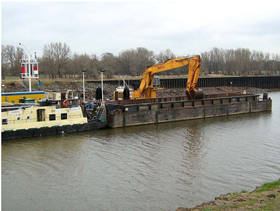
Bild 2: Erste Sedimentbaggerungen im Rothenseer Verbindungskanal - zukünftiger Unterer Vorhafen der Niedrigwasserschleuse RVK
