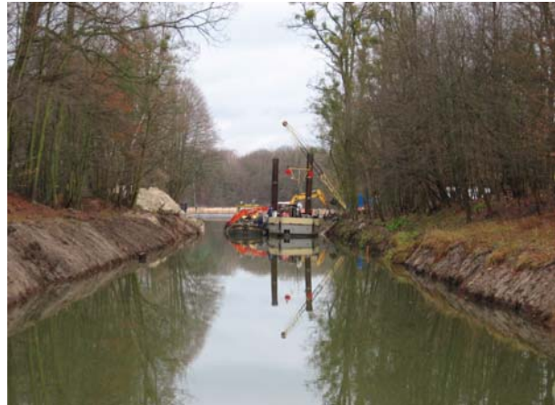
05.12.2006 – grundlegende Uferinstandsetzung bei WbG km 4,0
