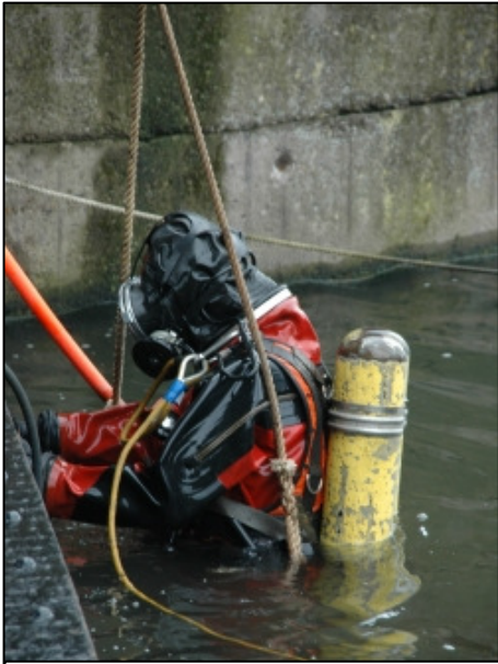
Ein Taucher untersucht eine Mauer des Drakenburger Wehrs, das instandgesetzt wird
