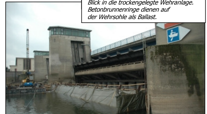
Die 40 Meter lange linke Wehröffnung wurde für Instandsetzungsarbeiten
