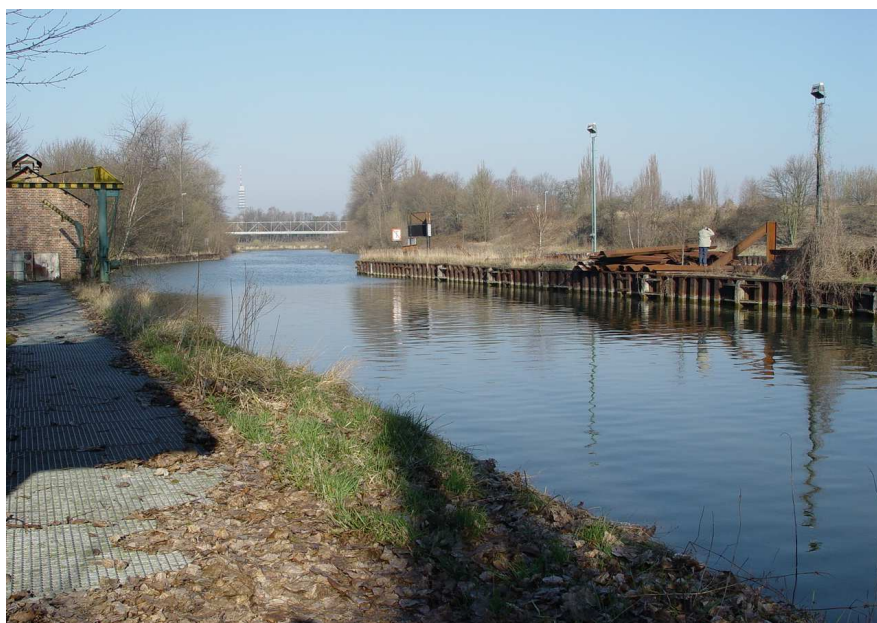
Blick vom Ölhafen zum Einfahrtsbereich des SKM am Mittellandkanal
