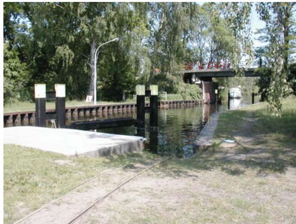
Bootseinsetzstelle Schleuse Vosswinkel, OHW km 88,05, Oberwasser
