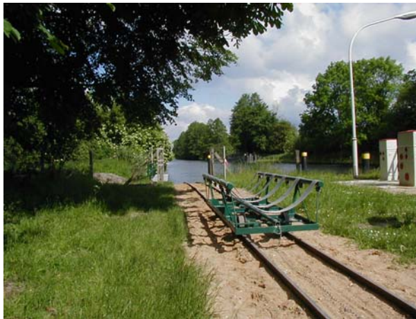
erneuerte Bootschleppe Wesenberg mit Slipwagen, OHW km 81,75
