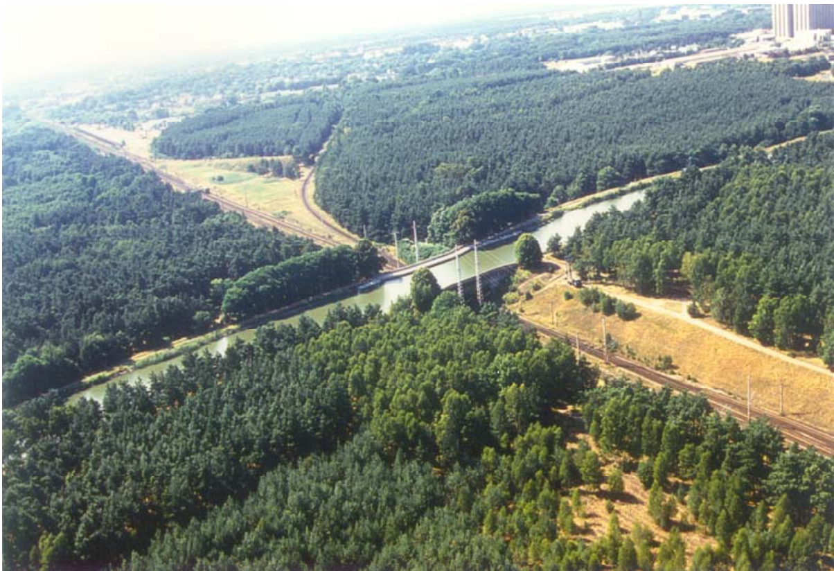
Kanalbrücke Eberswalde (Zustand vor 1998), HOW km 68,340, Bahn-km 47,4+200
