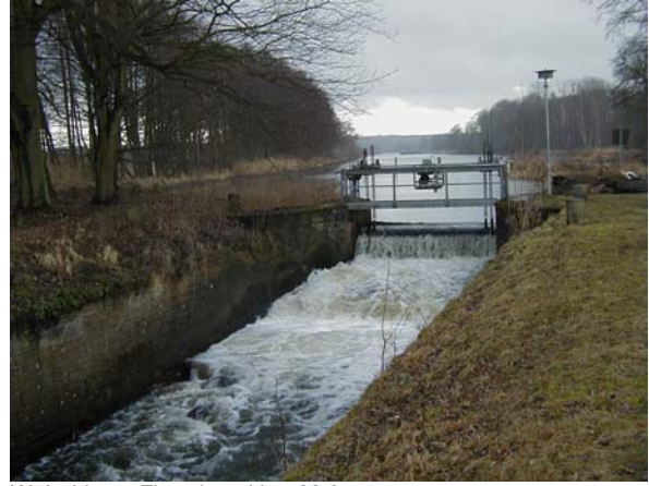
Wehr Liepe, Finowkanal km 88,9
