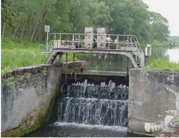
Wehr Stecher, Finowkanal km 83,37
