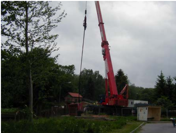
23.05.03 – Mit Hilfe eines Autodrehkranes werden an der Staustufe Stecher Spundbohlen für eine Baubehelfsbrücke eingebracht.
