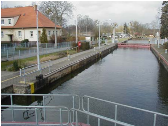
Schleuse Zehdenick, noch bis Mitte 2003 befindet sich die provisorische ÜZZ im Schleusenwärtergebäude, links im Bild.
