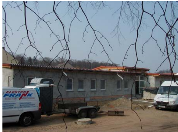
Baustelle des neuen Dienst- und Sozialgebäudes für den Außenbezirk Zehdenick, in dem die ÜZZ ab Ende 2003 auf Dauer eingerichtet wird.
