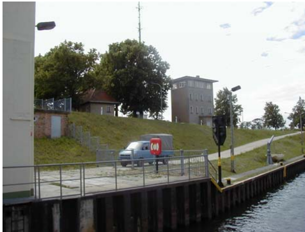
zentraler Steuerstand vor der Sanierung
